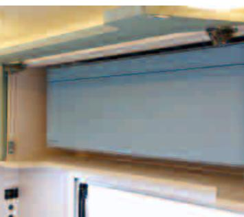
リビングエリアの上部にある家庭用エアコンは標準装備。吊り下げ棚の一部に組み込まれていて、室内のインテリアとよく馴染んでいます。扉を閉じた状態でも利用できるようになっています。
